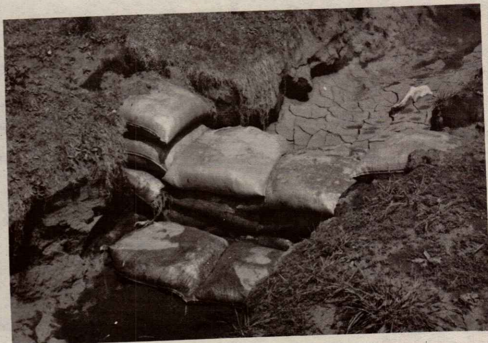
FIGURA 6.- Presa filtrante para el control de azolves, construida a base de costales de polipropileno rellenos de tierra. Ejido Parres. D.F.
