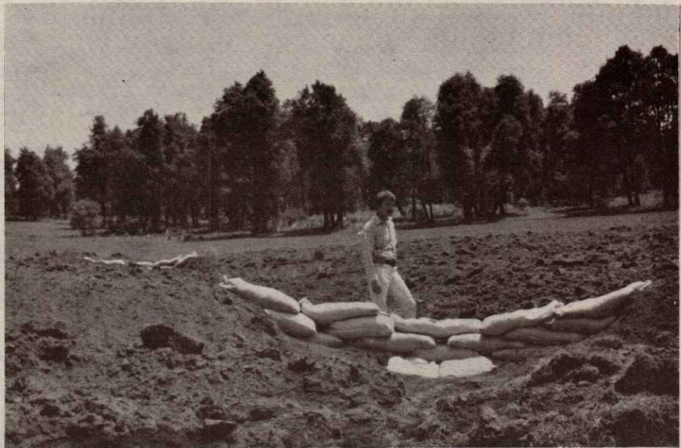
FIGURA 8.- Presa filtrante para el control de azolves, construida a base de costales de polipropileno rellenos de tierra. Esta estructura se construyó como obra complementaria de terrazas de formación paulatina.
