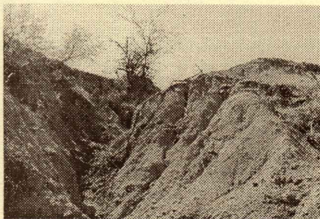
Figura 3. Erosión en cárcavas, localmente denominada "barranca" o "cantil".
